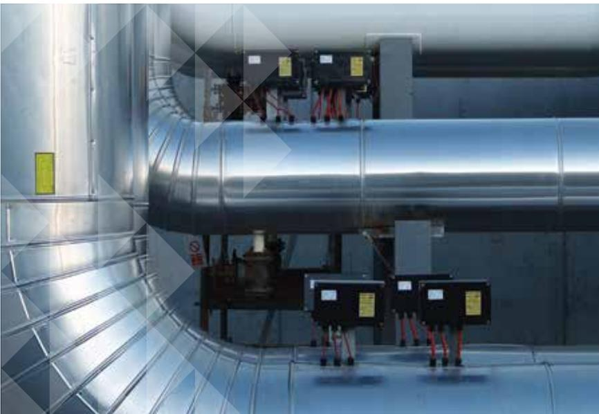
Solution de traçage électrique complète et entièrement homologuée, dotée d'un système de raccordement simple à installer pour les longues lignes de transfert.
