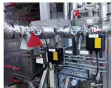
Robustes et résistants à la corrosion, les kits de raccordement Raychem sont rapides à installer, comportent peu de pièces et permettent de surveiller facilement l'état de l'alimentation et de la continuité.
