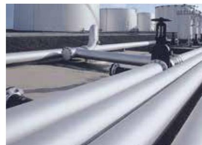
Concerne des fluides devant être maintenus dans une plage de températures étroite afin de conserver leur viscosité et de ne pas endommager les fluides comme la tuyauterie. C'est le cas notamment des lignes de soufre et d'acide acrylique.
