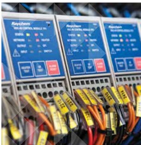
Les systèmes de régulation et de surveillance centralisés sont généralement installés dans des armoires, permettant le contrôle simultané de plusieurs circuits de traçage ou groupes de circuits. Ils proposent des fonctions évoluées telles que la mesure des niveaux de défaut à la terre et des courants de service, et fournissent une mine d'informations complémentaires relatives à la maintenance.
