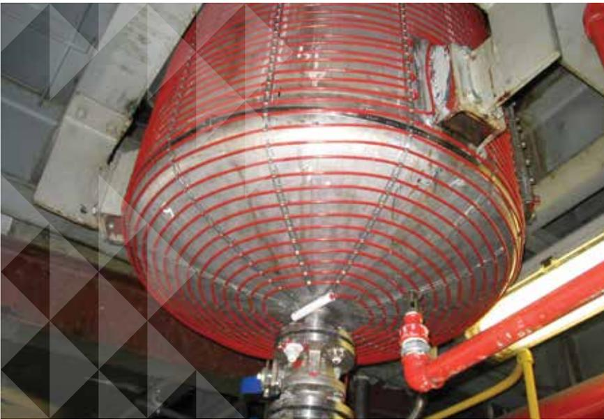
Maintien en température des fûts de stockage de fluides grâce aux rubans chauffants Raychem XPI.
