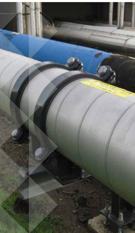
Les supports de tuyauterie installés sur le calorifuge garantissent un profil thermique uniforme sur toute la longueur de la tuyauterie.
